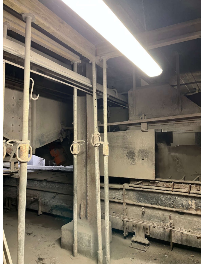
Annexe 1 : photos des étais présents dans le local d'extraction des mâchefers
